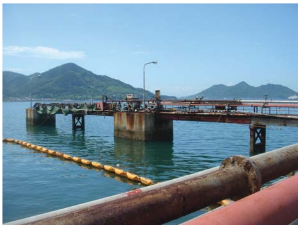
写真－1 既設栈橋状況
