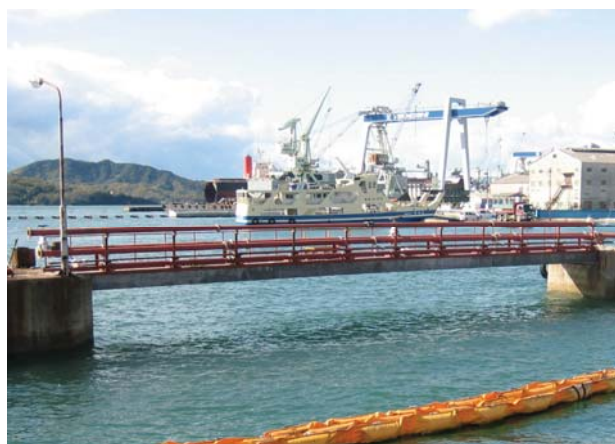
写真-3 完成状況
