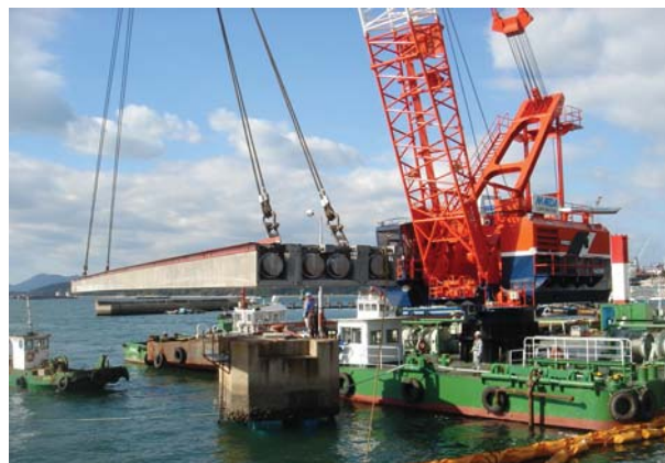
写真-2 主桁架設状況
