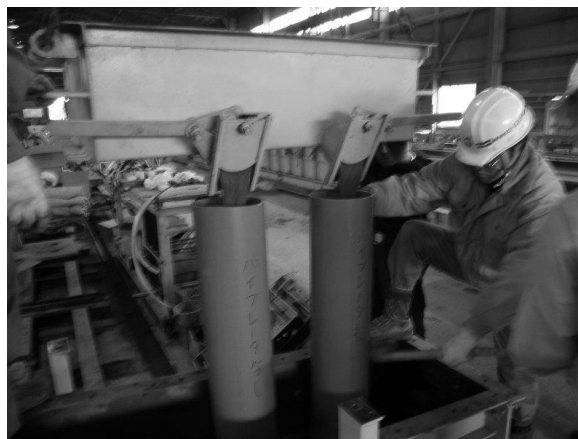
写真-解 5.3.1 鋼繊維の分散試験状況
