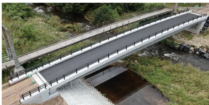
写真-2 完成状況
