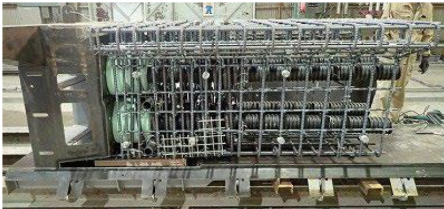
写真-3 試験体の配筋状況
