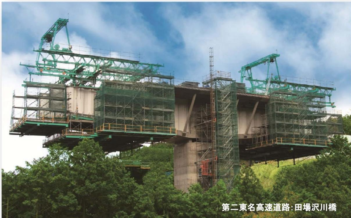
波形鋼板ウェブを用いた張出し架設工法
