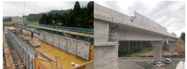
本所川橋 (西日本高速道路(株)、2011年)
