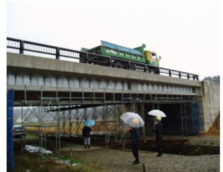
実橋載荷試験
