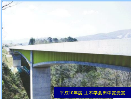
上伊佐布第二高架橋 (NEXCO中日本, 2011年) 2径間連続ストラット付き波形鋼板ウェブ箱桁橋
