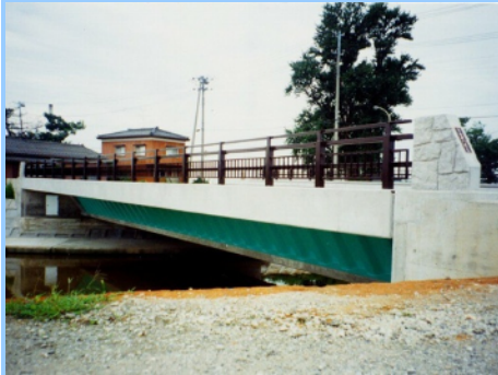
杉谷川橋下り線 (NEXCO西日本, 2007年) 6径間連続ラーメン波形鋼板ウェブ箱桁橋
