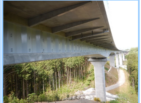
仁井田川橋 (NEXCO東日本, 2021年) Tラーメン波形鋼板ウェブ箱桁橋(+8径間2主版桁)
