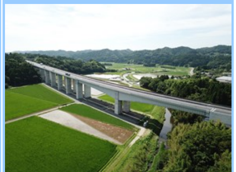
仁井田川橋 (NEXCO東日本, 2021年) Tラーメン波形鋼板ウェブ箱桁橋(+8径間2主版桁)
