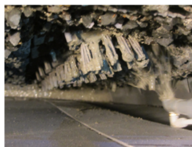
鉄筋防錆材塗布
