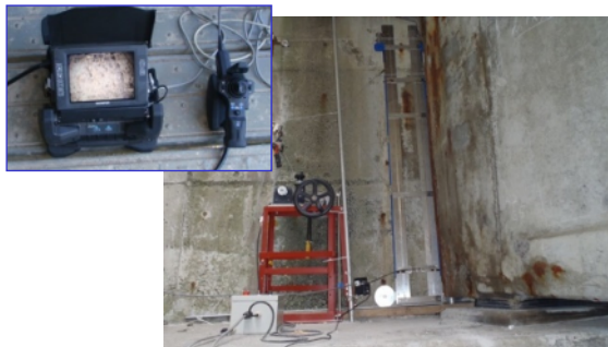
桁端狭隘部の損傷状況調査
