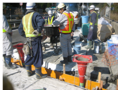
断面修復材充填
