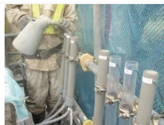
充填完了後のヘッド圧付与
