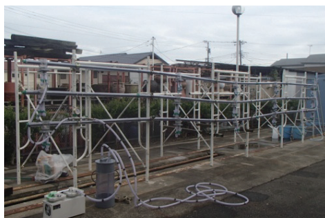
実物大試験体による充填確認
