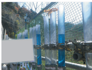
水溶液注入状況 (自然流下)
