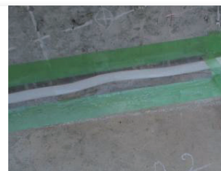
ひび割れ部養生
