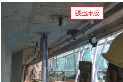
床版横締めPC鋼棒への事例
