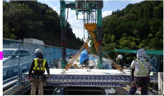
取替床版架設(二期施工)
