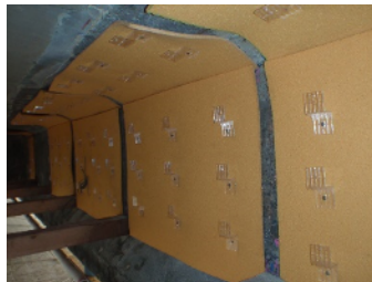
取付金具、保水スポンジの設置
