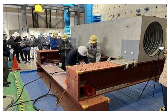
施工性確認試験(公開試験)
