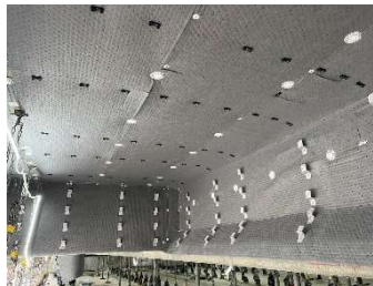
取付金具、吸水不織布の設置
