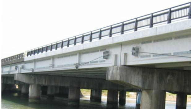
【外ケーブル設置例 (PC箱桁橋)】
