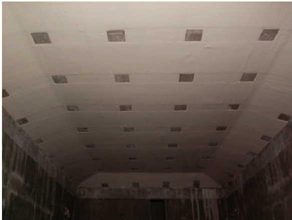
【炭素繊維シート 主桁曲げ補強】
