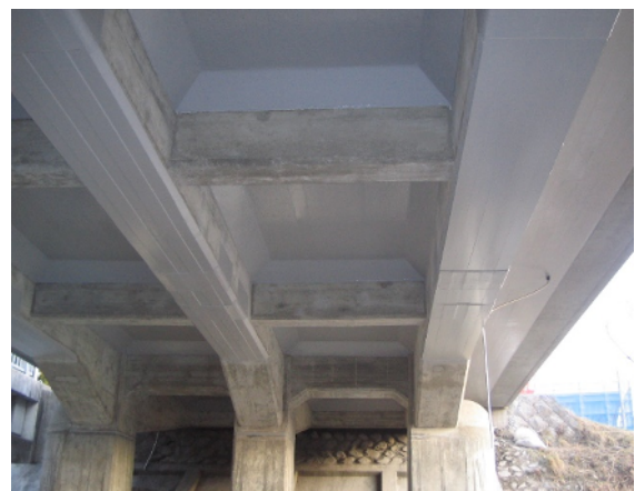
【炭素繊維プレート 主桁曲げ補強】
