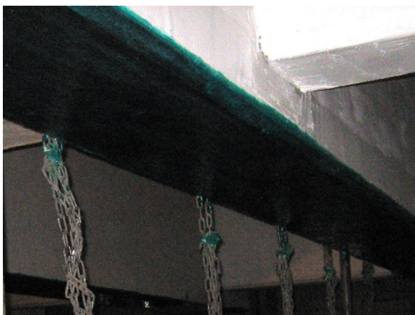
【炭素繊維シート 主桁曲げ補強】
