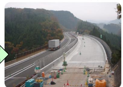
※事前にPCaPC床版に壁高欄を打設しておくことで工期短縮を図れます。(例:フルキャスト壁高欄+半断面)
