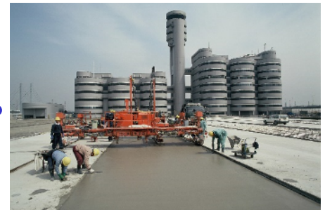
コンクリート打設・養生
