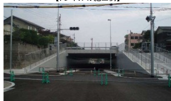
【トンネルの施工例】
