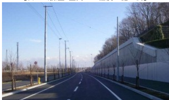
【自立式擁壁：壁高8.5m程度の施工例】
