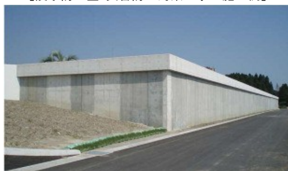
【浸水防止壁：災害防止対策工事の施工例】
