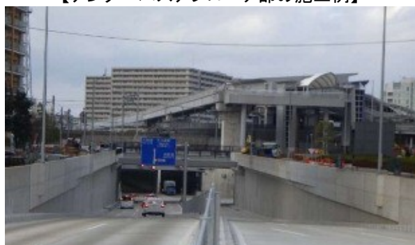
【アンダーパスアプローチ部の施工例】
