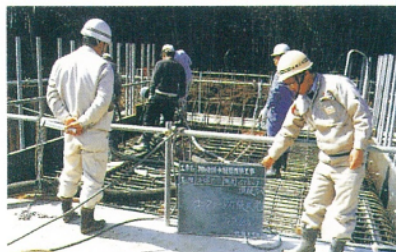
② 上床版の施工
