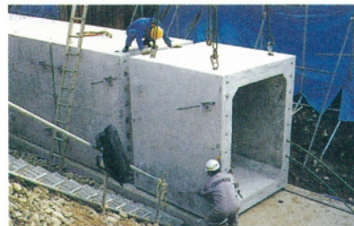
② 樋管ブロック 組み立て作業
