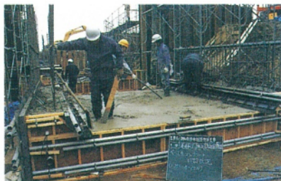
① 下床版の施工
