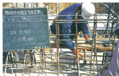
④ グラウト作業
