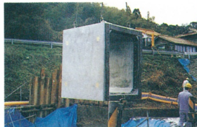
① 工場製作 PC樋管現場搬入
