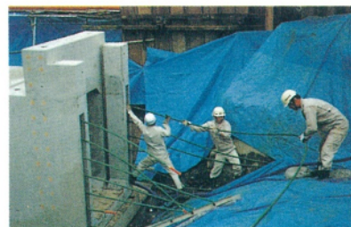
③ PC鋼材挿入作業
