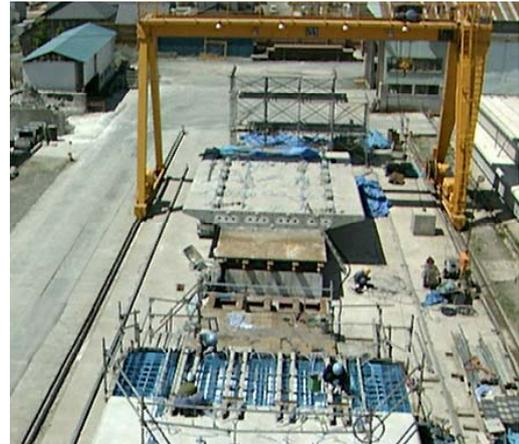
写真 - 4 主桁製作状況
