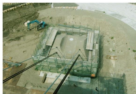
写真 - 15 アンカレイジ打設完了
