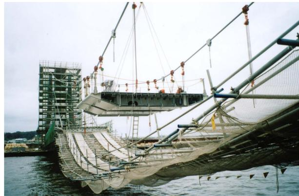
写真 - 24 鋼桁架設状況 - 2
