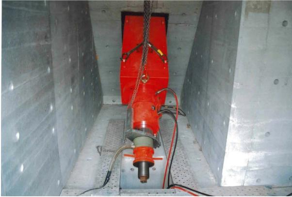
写真 - 18 ジャッキ取付け状況 (アンカ側)
