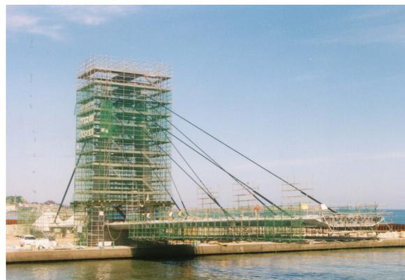
写真-17 張出し架設完了
