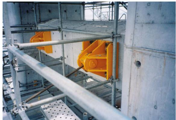
写真 - 21 仮斜材取付け状況 (主塔側)
