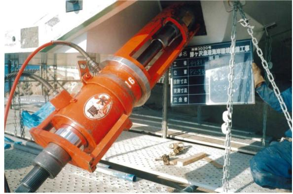
写真 - 19 ジャッキ取付け状況 (主桁側)
