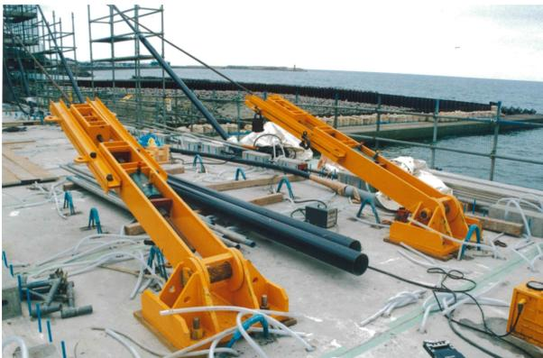
写真 - 20 仮斜材取付け状況 (主桁側)
