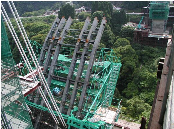
写真 2 メラン材架設状況
