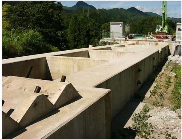
写真 8 バックステー部材（水平梁）
