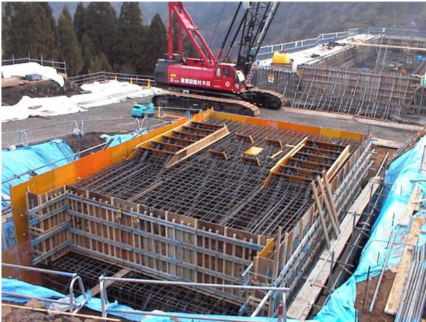
写真 7 アンカーアバットの施工
