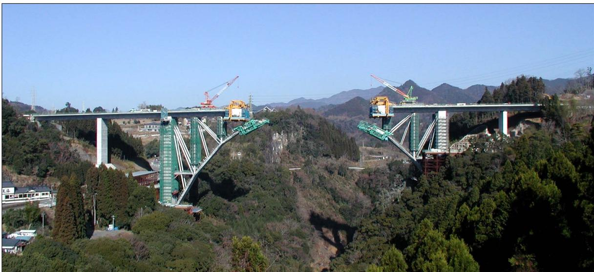
写真 - 1 トラス張出し架設状況
