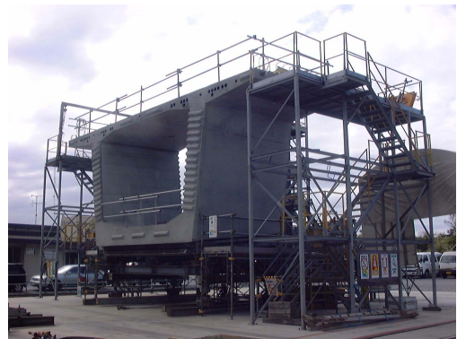
写真-6 横締め緊張足場
