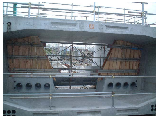
写真-10 隔壁の施工
