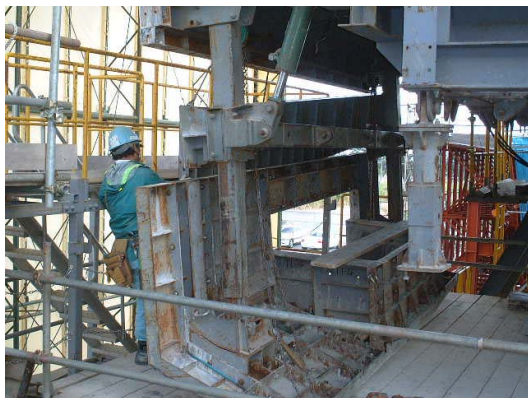
写真-9 内枠組替え状況
