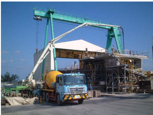
写真-5 打設状況
