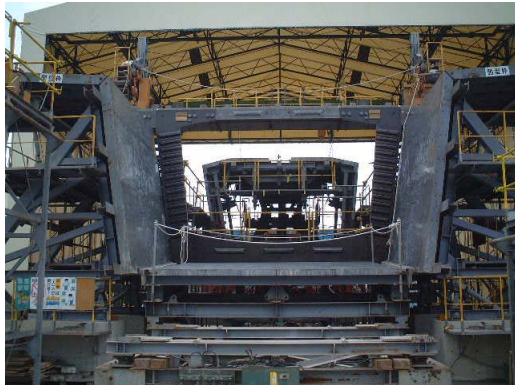
写真-7 端枠設備
