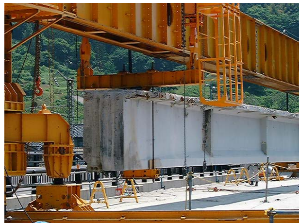
写真 - 6 主桁撤去状況
