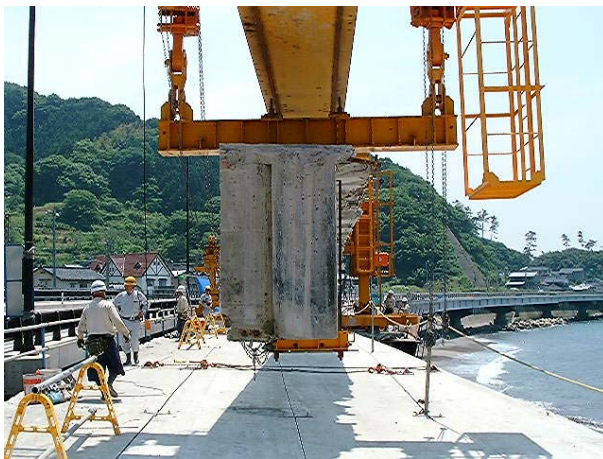
写真 - 5 主桁撤去状況
