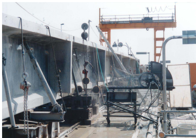
写真 - 7 主桁切断状況
