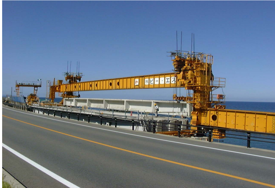
写真 - 4 主桁撤去状況 全景
