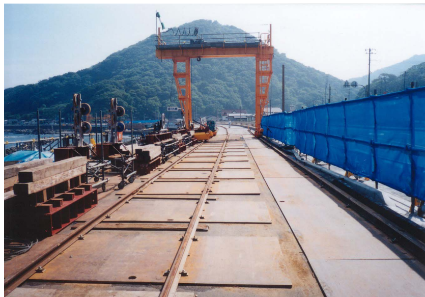
写真 - 3 A1解体ヤード
