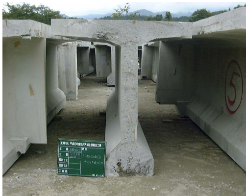
写真 - 10 切断面充填状況
