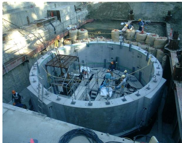
写真-1 セグメント設置完了状況
