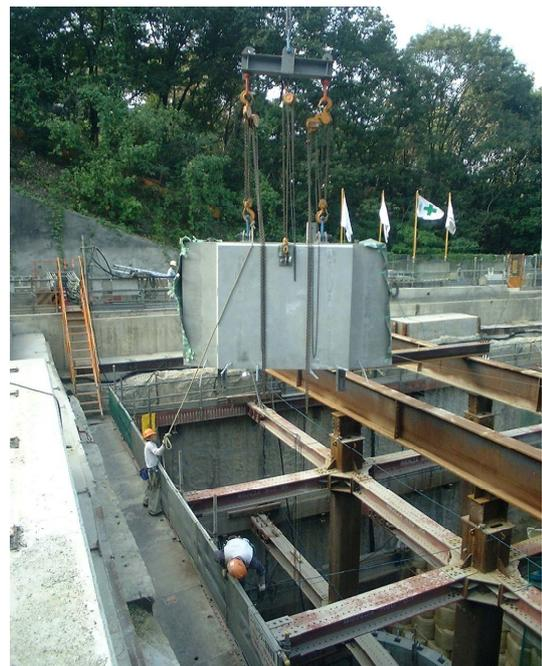
写真 - 6 セグメント吊り下ろし状況
