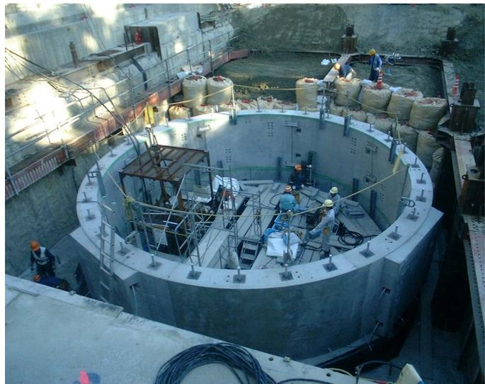
写真 - 9 セグメント設置完了状況(上から)
