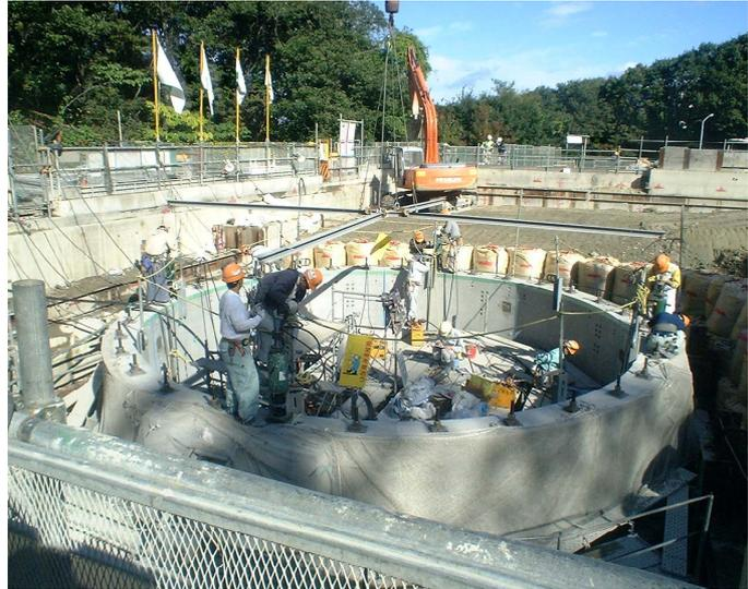
写真 - 8 鉛直PC鋼棒緊張状況
