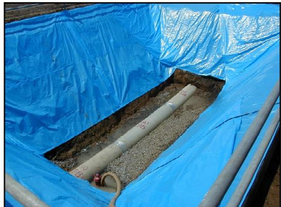
写真 - 13 実証実験状況 (管路構築完了 R=60m)
