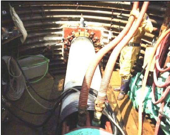
写真 - 10 実証実験状況 (推進管掘進状況)
