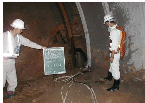
写真 10 注入式レッグボルト注入状況
