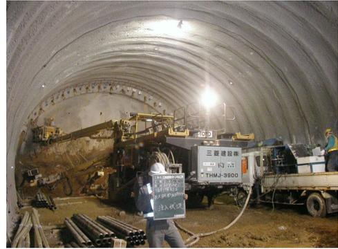
写真 4 AGF工 施工状況
