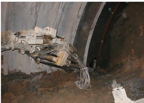
写真 9 注入式レッグボルト打設状況
