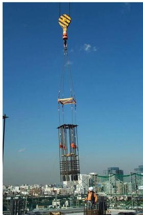
写真-1 柱筋吊り込み
