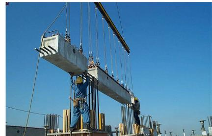
写真-3 PCa梁架設
