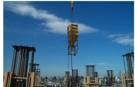
写真-4 Vコン打設
