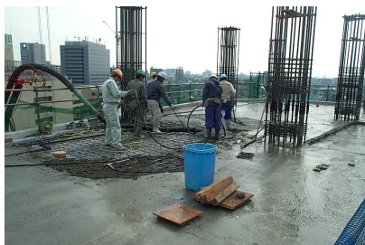
写真-7 Hコン打設
