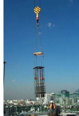
写真-5 柱筋吊り込み
