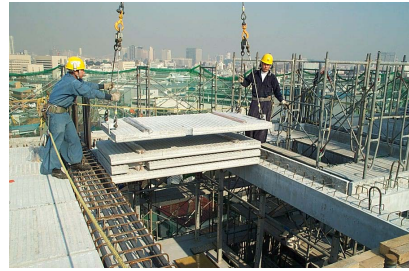
写真-4 バリアックスの敷設
