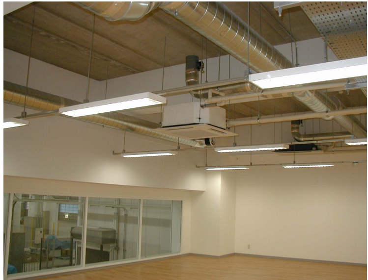
写真-7 倉庫内が見える食堂：柱・梁はケイカル板被覆
