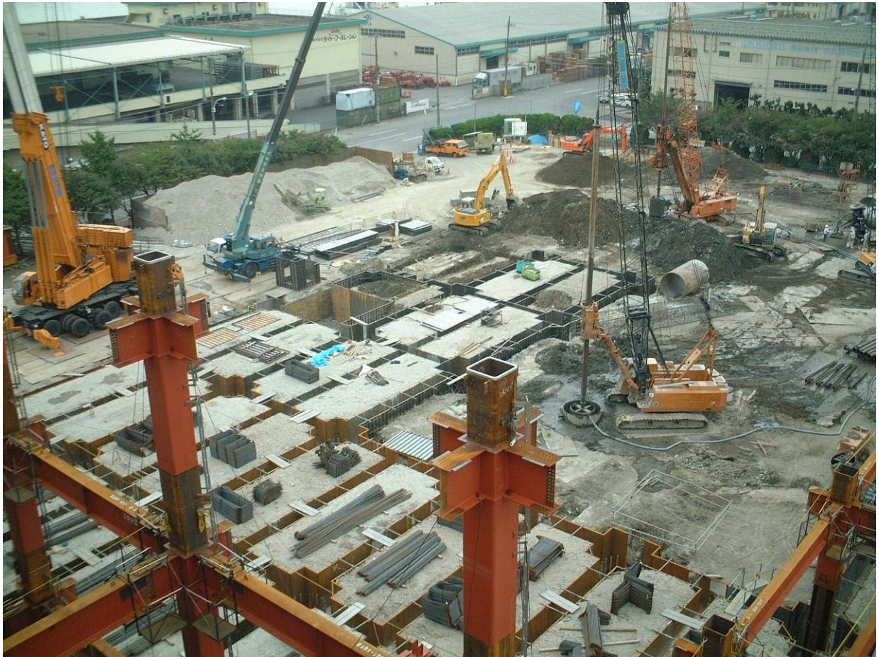
写真-12 工事ラップ状況：A工区鉄骨上から見たB2工区。右下鉄骨はB1工区
