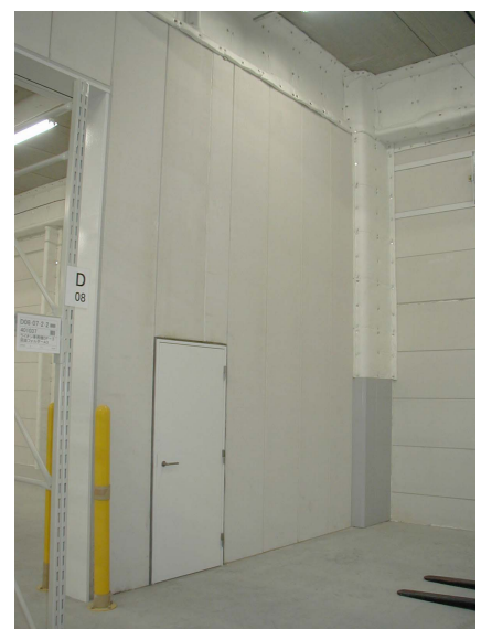
写真-14 防火区画のALC板
