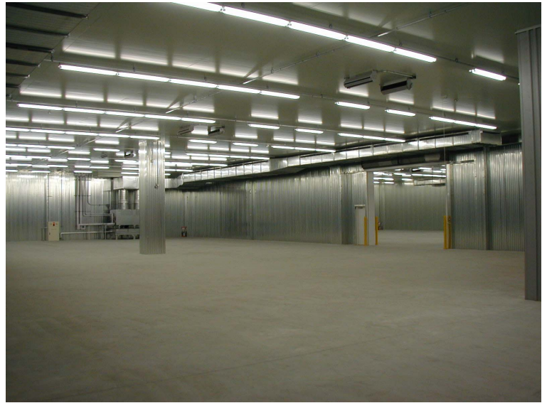
写真-11 定温庫：ダクト吹き状況
