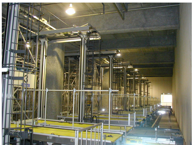
写真-9 自動倉庫内耐火被覆：ロックウール
