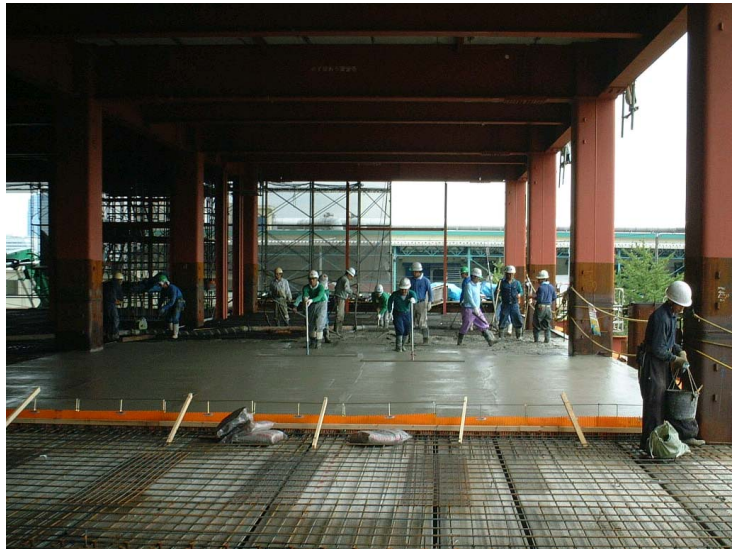
写真-15 合成床板コンクリート打
