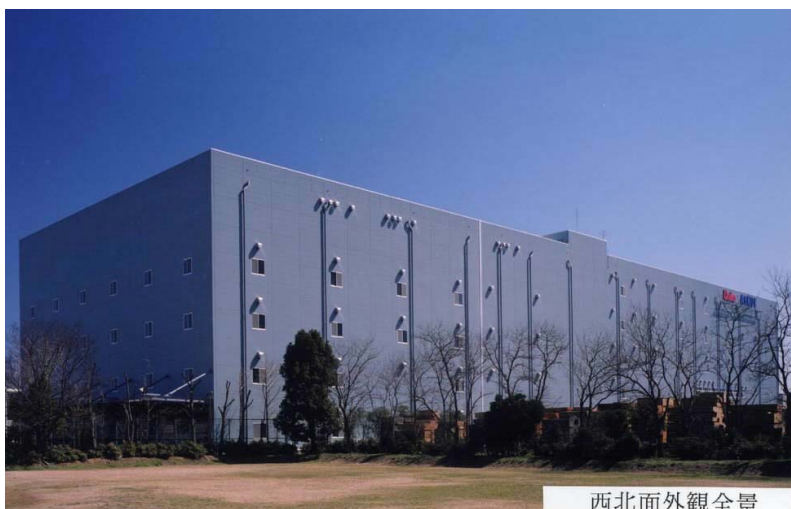
写真-4 外壁状況
