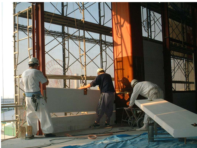
写真-13 ALC板:金物位置に注目
