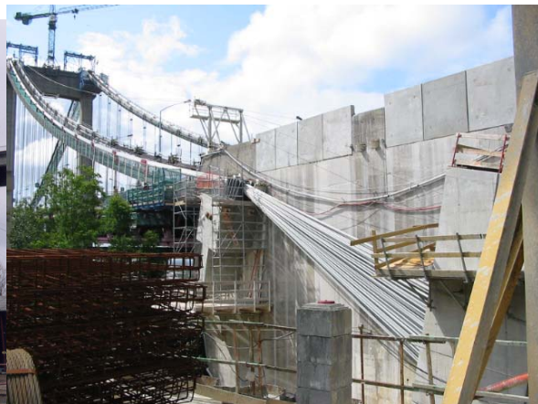
写真 - 3 新アンカレッジ（右岸）
