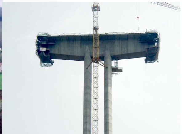
写真 - 6 橋脚形状
