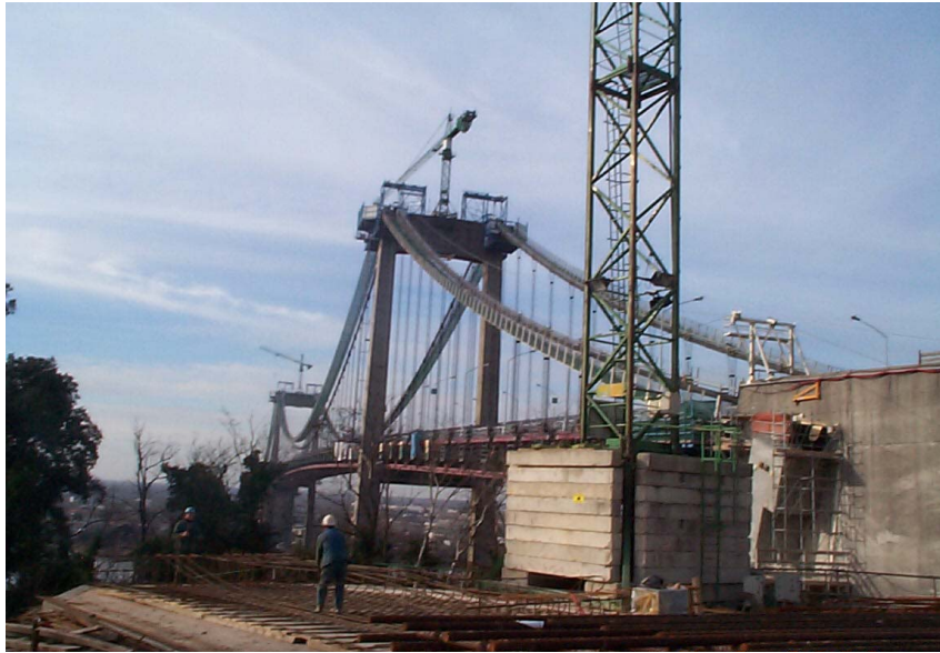
写真 - 1 Aquitaine 橋全体写真
