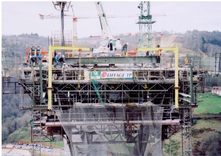
写真 - 5 張り出し装置
