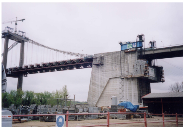
写真 - 2 新アンカレッジ（左岸）
