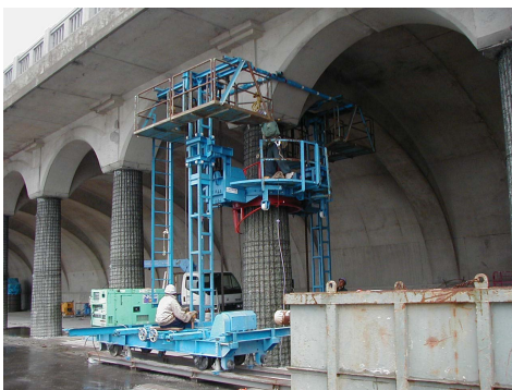
写真 - 5 PC鋼線巻き立て(上からの施工)
