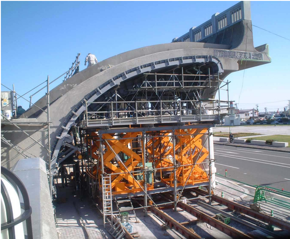
写真 - 7 移動型枠(入口側)
