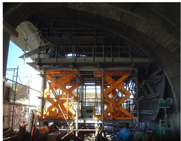
写真 - 9 移動型枠(内側)
