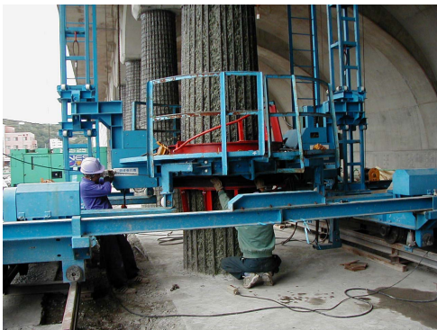
写真 - 2 PC鋼線巻き付け
