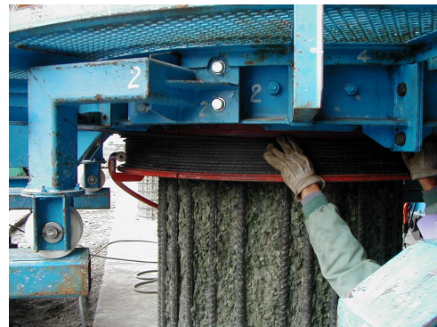
写真 - 3 下ドラムへのPC鋼線 巻き付け状況
