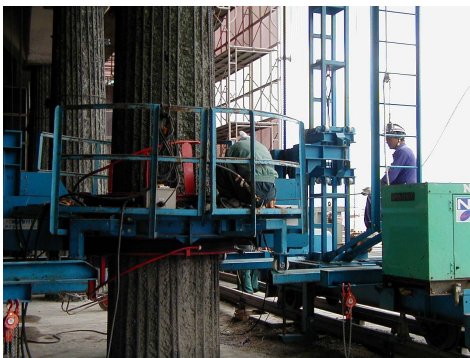
写真 - 4 PC鋼線巻き立て (下から上へ)
