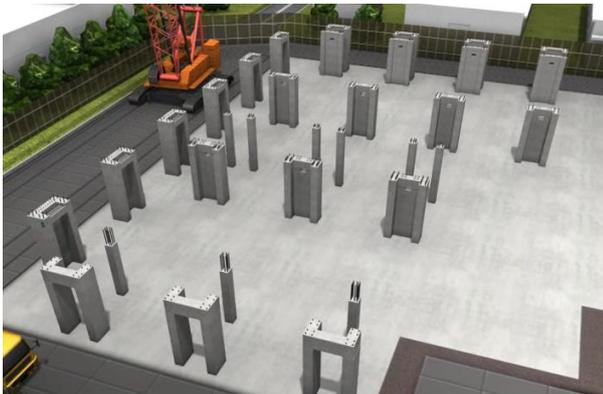
図-1 柱およびパネルゾーン部材架設時状況
