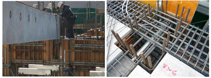
写真-2 梁部材架設状況及びパネルゾーン内納まり状況
