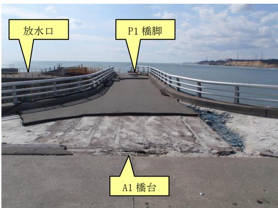
写真-1 A1~P1主桁の被災状況(A1よりP1を望む)
