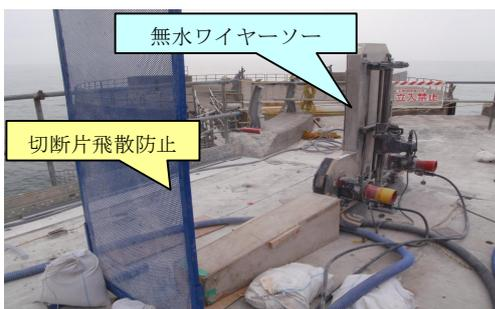
写真-3 無水コンクリート切断工法による施工状況
