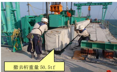
写真-4 門型架設機を用いた主桁撤去状況
