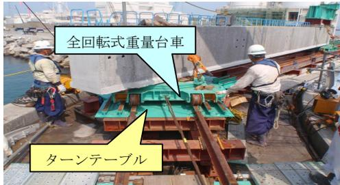
写真-2 ターンテーブルと全回転式重量台車
