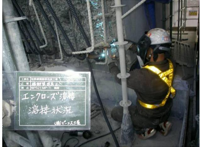
写真-5 エンクローズ溶接作業状況
