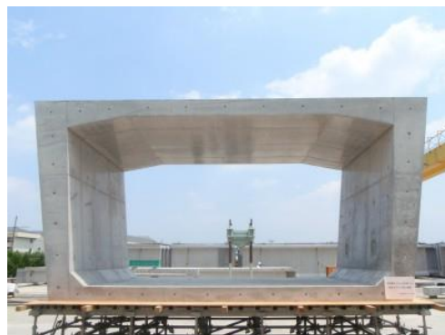
写真-1 試験体外観 (全景)
