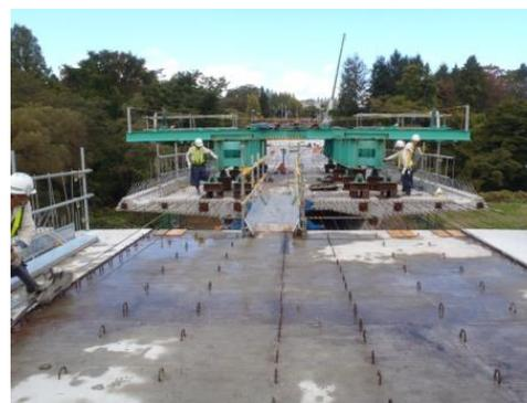
写真-3 吊支保工の移動状況
