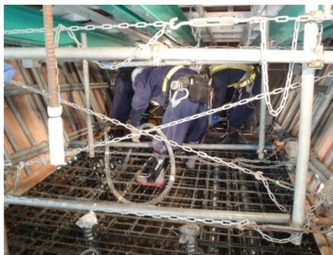
写真-4 箱桁内部の打設状況
