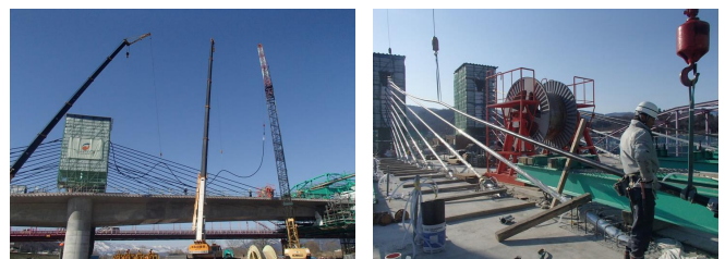
写真-4 斜材架設
