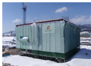
写真-1 養生外観
