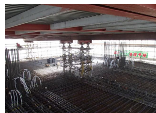
写真-2 養生内部
