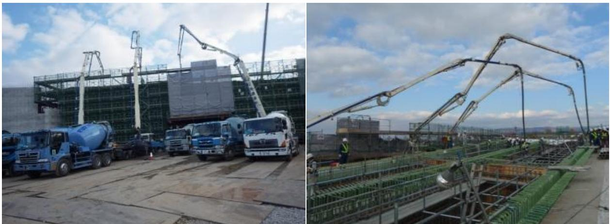
写真-1 コンクリート打設状況
