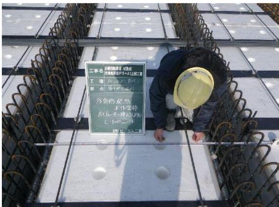
写真-1 埋設型枠設置状況
