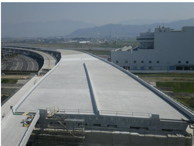
写真-1 完成写真 (終点側から)
