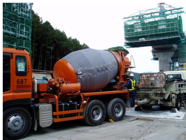
写真-1 ドラム養生カバーの設置
