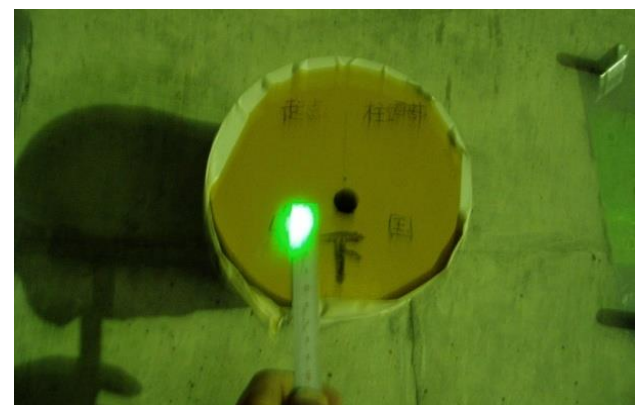
写真-6 定着部でのターゲット設置状況
