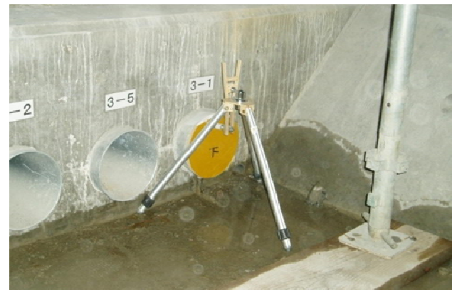
写真-5 偏向部でのレーザー設置状況
