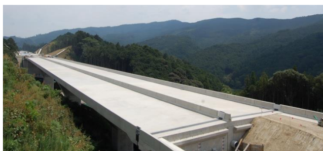
写真-1 北新戸橋 完成写真
