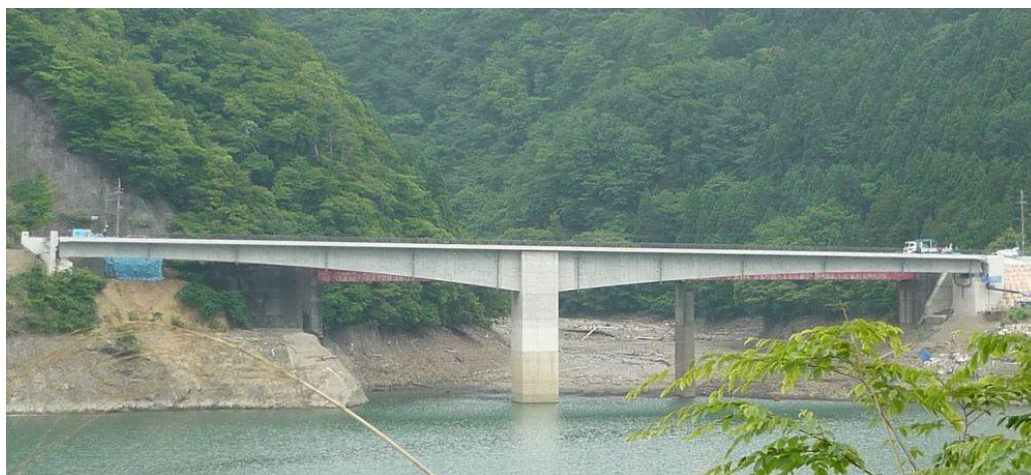
写真-2 橋体完成状況
