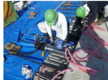
写真-4 ロングノーズを使用した緊張作業状況
