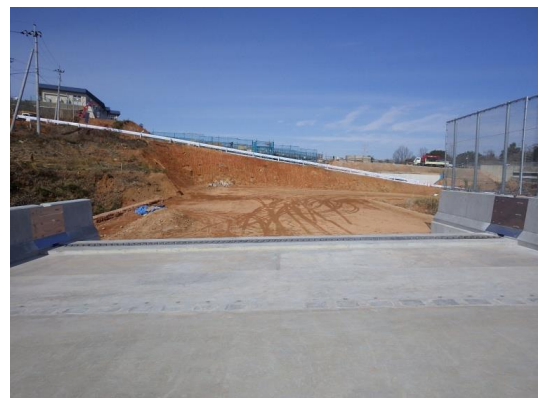
写真-5 延長床版システム施工完了全景
