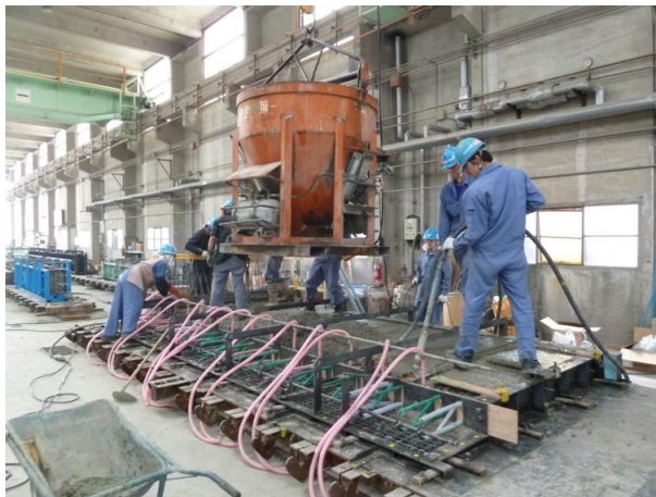
写真-2 延長床版製作状況
