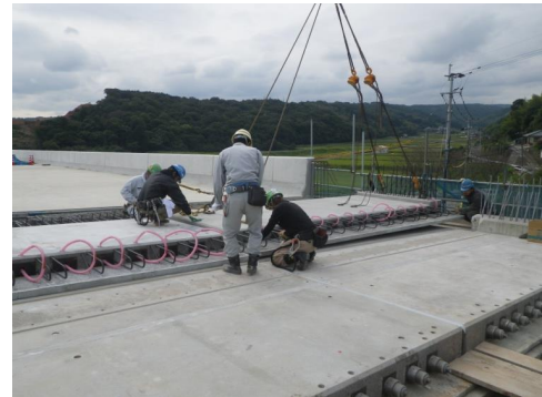
写真-3 延長床版架設状況
