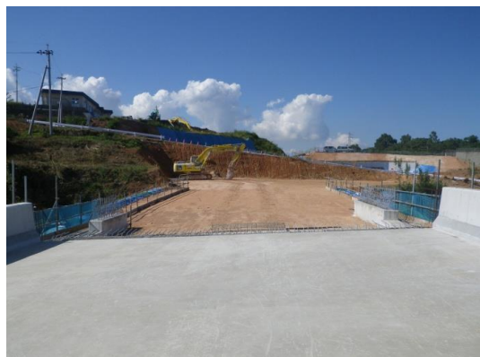
写真-1 延長床版システム施工前状況
