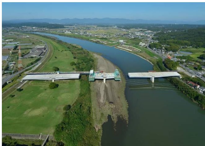
写真-1 施工中の新相生橋
