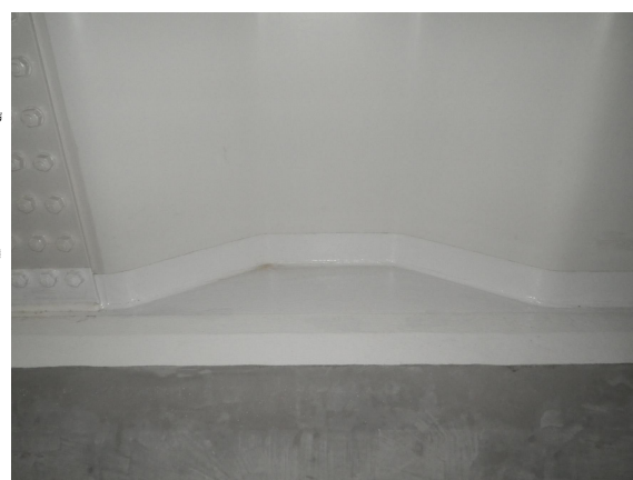
写真-3 アクリル系ゴム塗装施工状況
