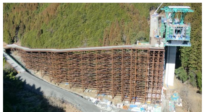
写真-2 栈橋全景
