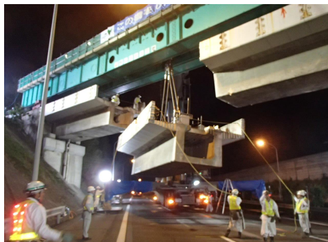
写真-2 切断ブロック降下状況
