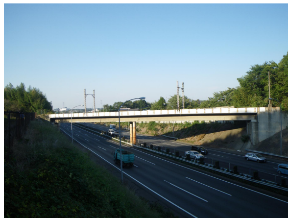
写真-1 葛袋3号橋撤去前
