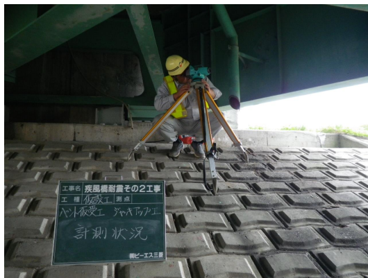
写真-5 計測状況 (デジタルレベル)
