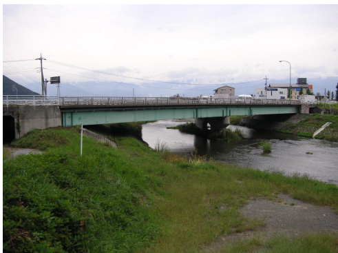
写真-1 アンダーピニング施工前
