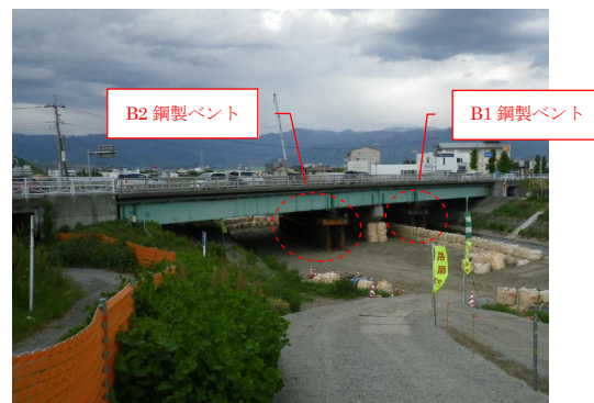
写真-2 アンダーピニング施工完了
