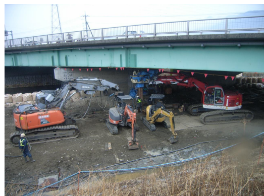
写真-3 H鋼基礎杭打設状況
